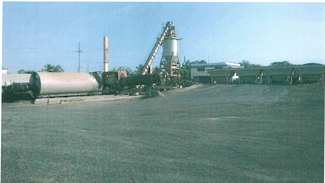
Imagen 1. Instalaciones planta El Caliche.
