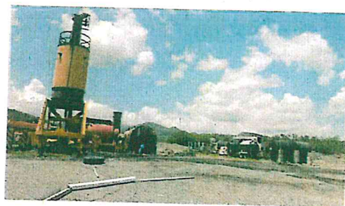
Imagen 5: Almacenamiento de AC-30 y Silo
