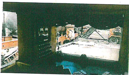
Imagen 4: Área de control de planta
