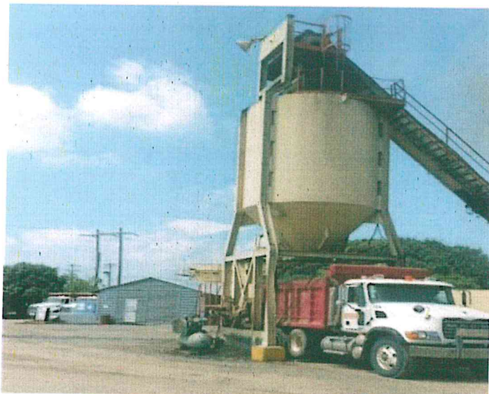
Imagen 1. Instalaciones planta ECOCISA, Santiago.
