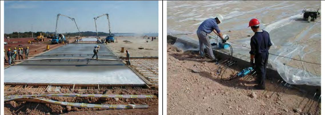
**Fotos 07 y 08:** Ejemplo de pavimento de hormigón postesado.
