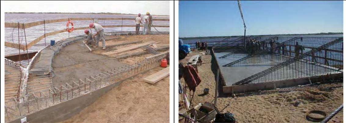
**Fotos 09 y 10:** Ejemplo de construcción de muro de atraque.
