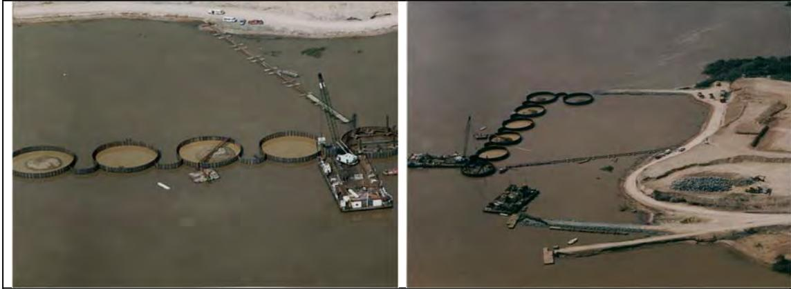
**Fotos 01 y 02:** Ejemplo de Celdas de tablestacas metálicas.
