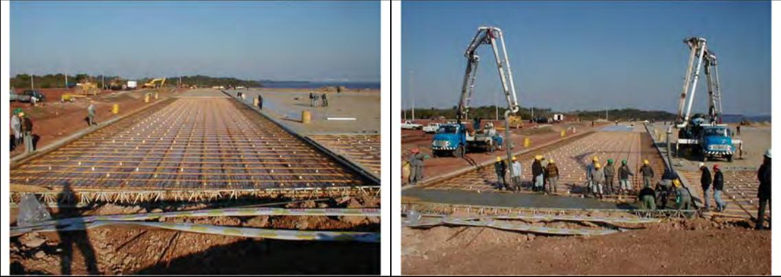
**Fotos 05 y 06:** Ejemplo de pavimento de hormigón postesado.
