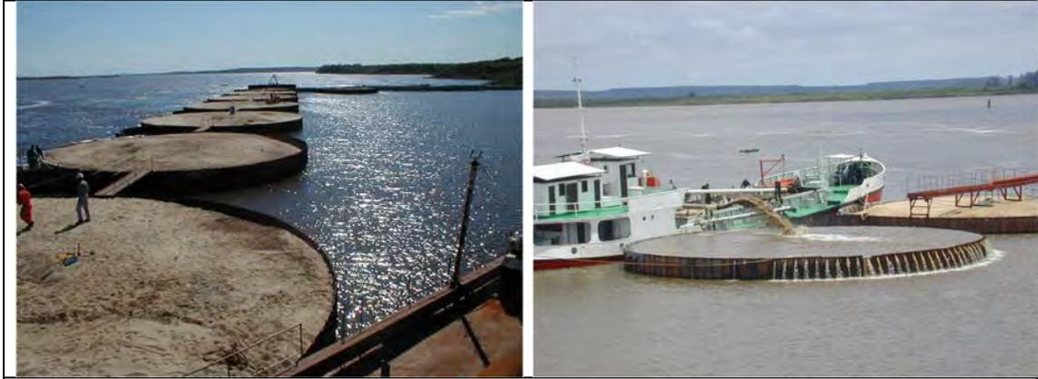
**Fotos 03 y 04:** Ejemplo de Celdas de tablestacas metálicas.
