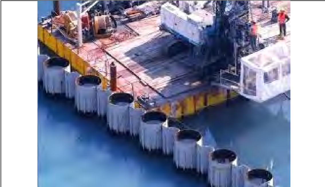
**Foto 03:** Ejemplo de muro de contención tipo Combi Wall.
