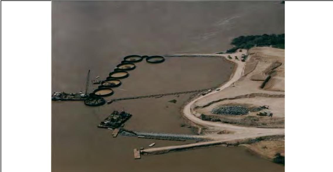
**Foto 04:** Ejemplo de Celdas de tablestacas metálicas.
