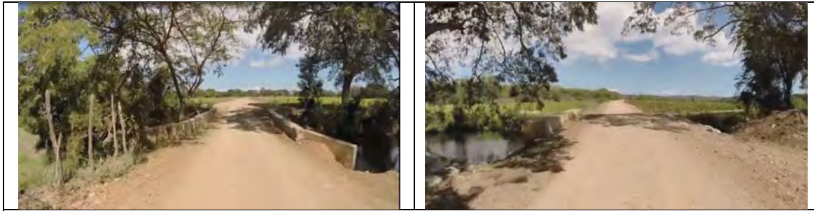
Fotos 17 y 18: Puentes en cruces de cursos de agua a 2,5 y 2,0 km antes de Laguna Verde.
