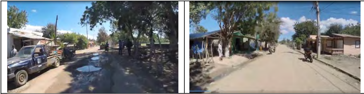
Fotos 05 y 06: Estado del pavimento en el tramo de la Carretera 20 dentro de la sede de Palo Verde. Observar el movimiento de vehículos y motos.
