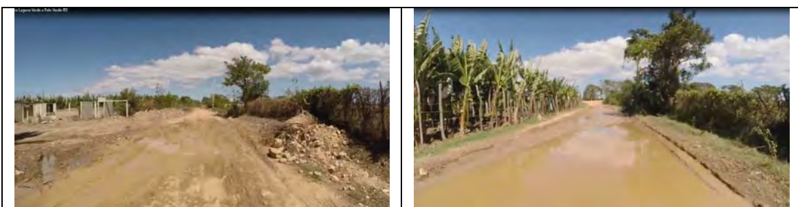
Fotos 09 y 10: Estado de conservación de la carretera de tierra justo después de salir de Palo Verde. Observar los agujeros y los puntos de acumulación de agua.
