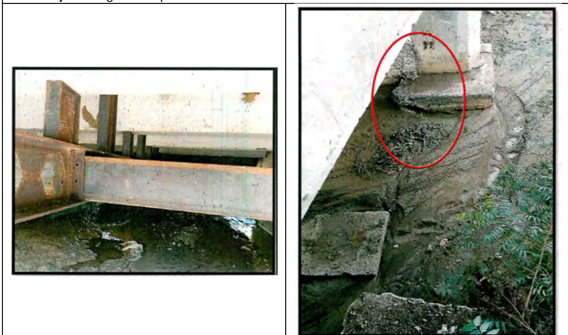
Foto 03: Imagen del puente 25.
