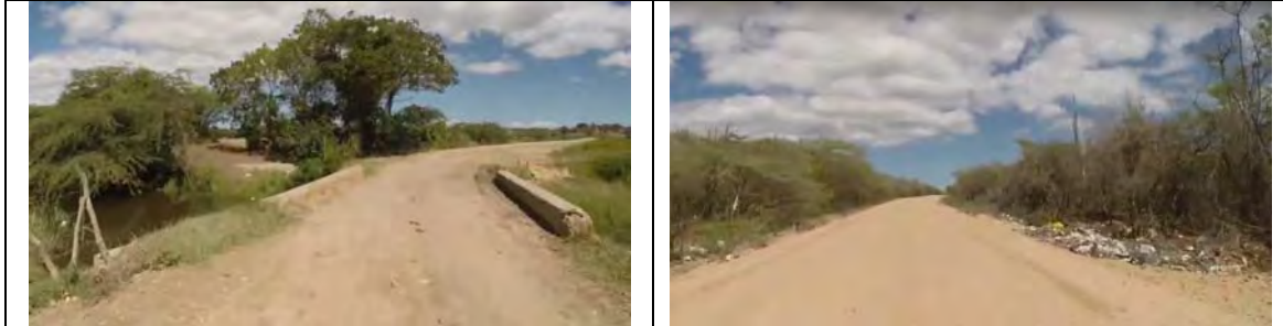
Foto 19: Puente en cruce de curso de agua a 1,6 km antes de Laguna Verde.
