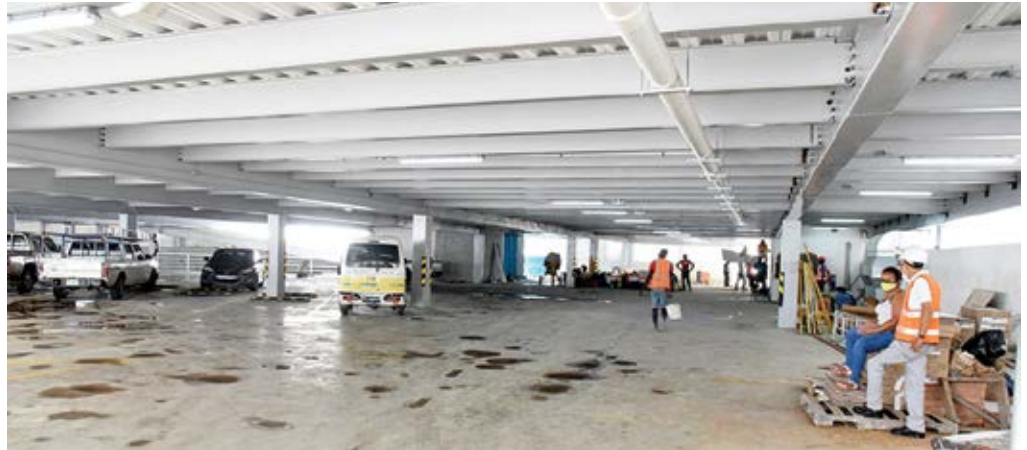
Este moderno parqueo se pondrá en servicio a final del año.
