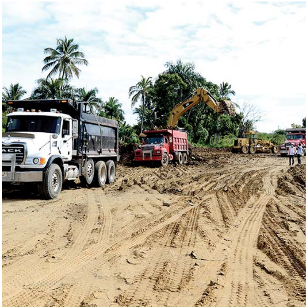
Los trabajos de construcción de la circunvalación de Los Alcarrazos se desarrollan con normalidad.
