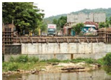
El muro de gaviones en la calle El Carmen en Las Terrenas.
