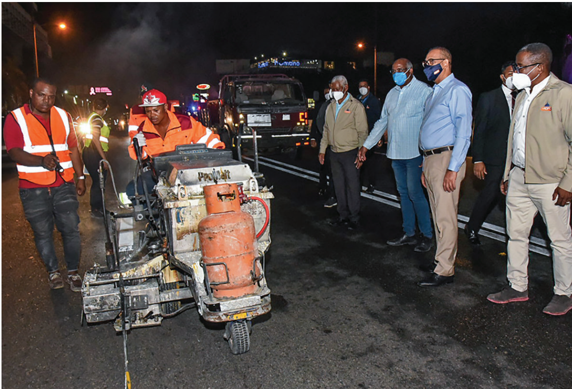
El ministro de Obras Públicas supervisa el asfaltado de una avenida del Distrito Nacional.
