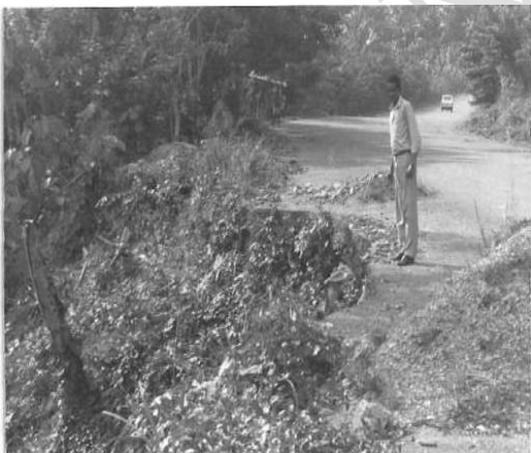
Erosión plataforma severidad alta
