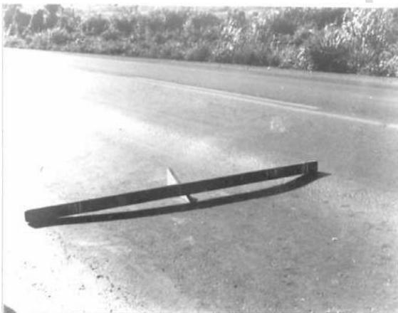
Ahuellamiento severidad baja con desplazamiento lateral
