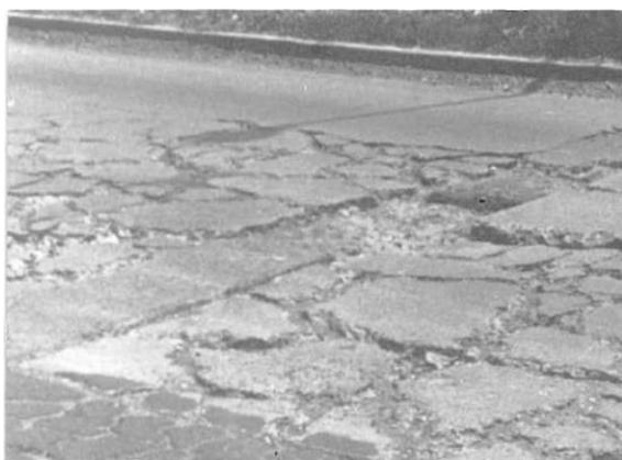
Fisura en bloques severidad alta
