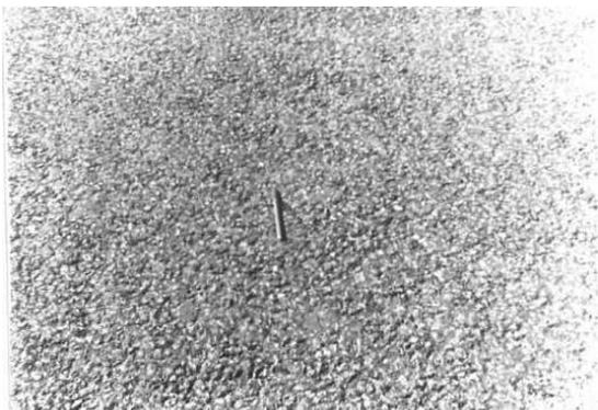
desprendimiento severidad baja en tratamiento asfáltico
