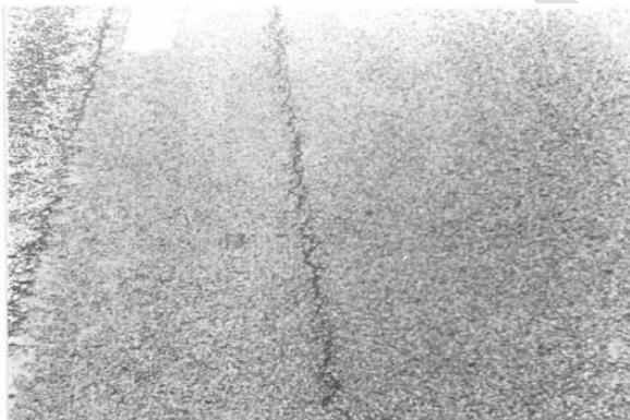
agrietamiento de borde severidad baja
