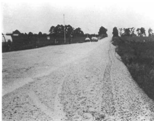
Erosiones debido a excesiva caída
