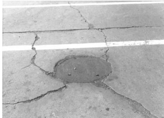
Fisura inducida (estructura fija)
