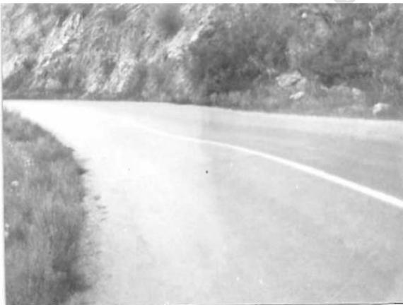
Hundimiento severidad baja
