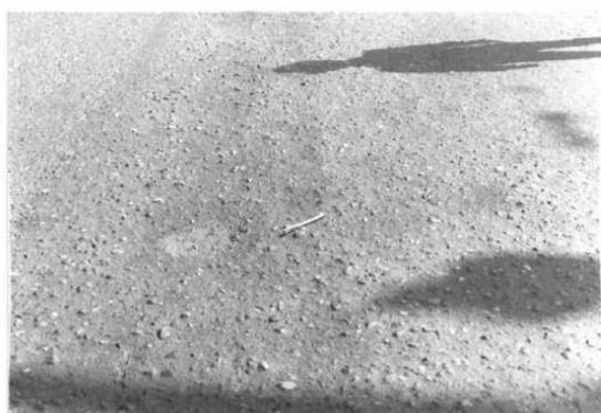
desprendimiento severidad alta en carpeta asfáltica
