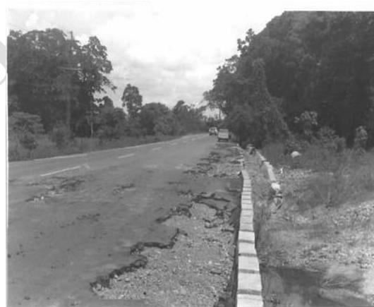
Deficiencia drenaje, insuficiencia obras de desagüe
