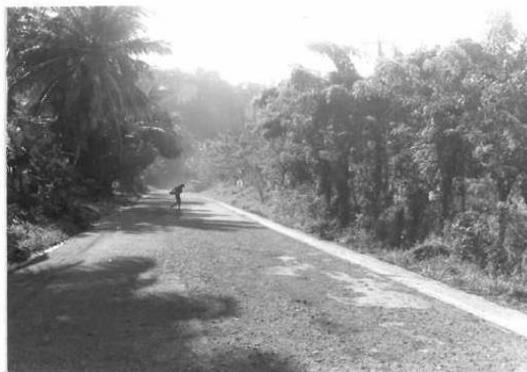
desprendimiento severidad alta en carpeta asfáltica
