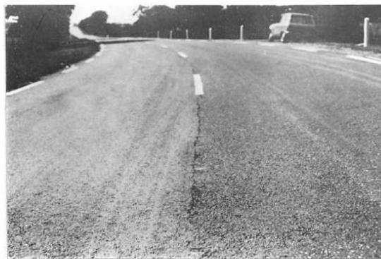
fisura de junta longitudinal severidad baja
