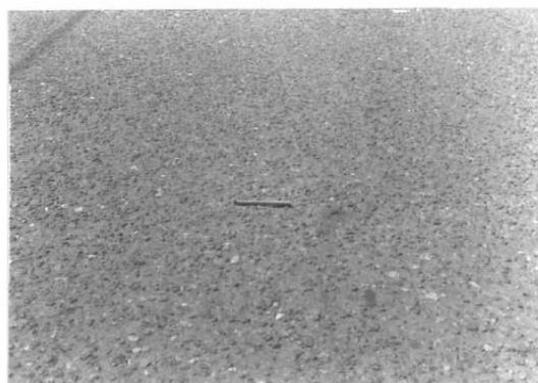
desprendimiento severidad baja en carpeta asfáltica
