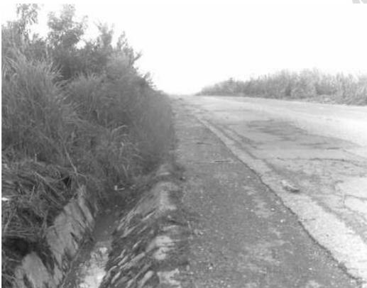
Deficiencia drenaje, obstrucción cuneta ensanchada
