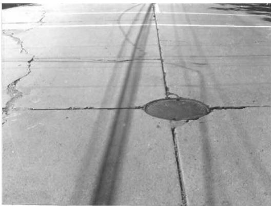
Fisura inducida (sustituye Junta)
