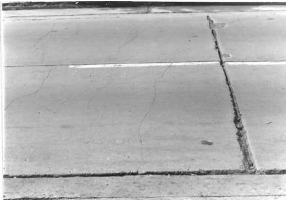
Fisura transversal severidad baja
