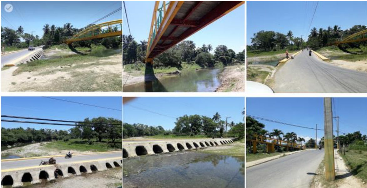
Ilustración 2. Puente badén y peatonal existentes. Río Veragua. Accesos
