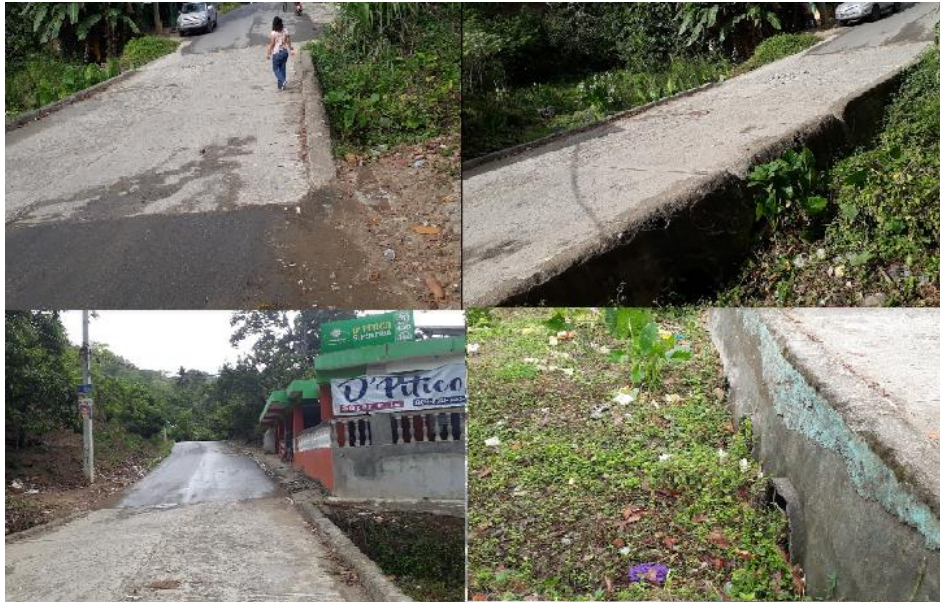
Ilustración 7: Imágenes del puente No. 3 en el camino Naranjo Dulce
