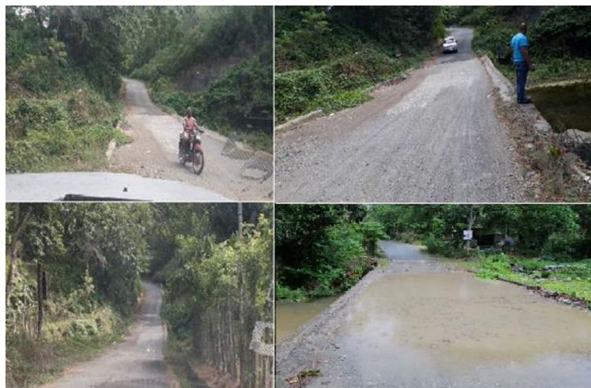
Ilustración 5: Imágenes del puente No. 1 en el camino Naranjo Dulce
