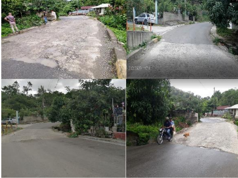
Ilustración 6: Imágenes del puente No. 2 en el camino Naranjo Dulce
