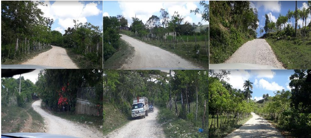
Ilustración 2 Situación actual del camino existente
