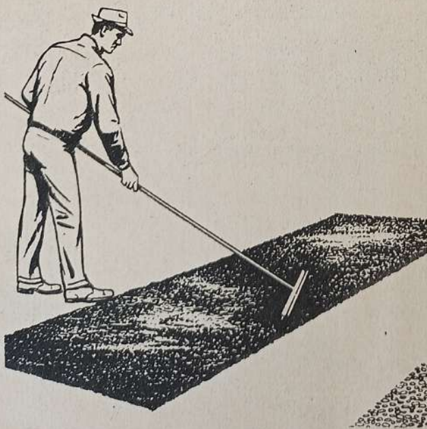
Fig. Núm. 5 - Extendiendo la Mezcla.
