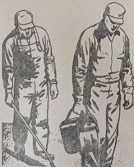
Fig. Núm. 25 - Sellando la Grieta con Cubo Especial de Vaciar y Enjugador de Goma.
