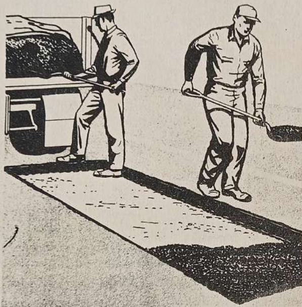
Fig. Núm. 4 - Rellenando el Hoyo con Mezcla de la Planta.
