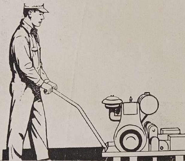
Fig. Núm. 13 - Compactando con Compactador de Plato Vibratorio.
