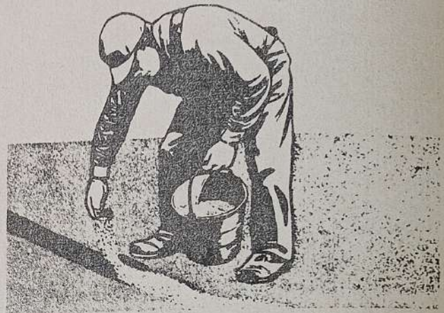
Fig. Núm. 26 - Regando la Superficie con Arena Seca.
