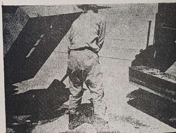
Fig. Núm. 65 - Llenando el Hoyo con Material del Montón de Acopio.
