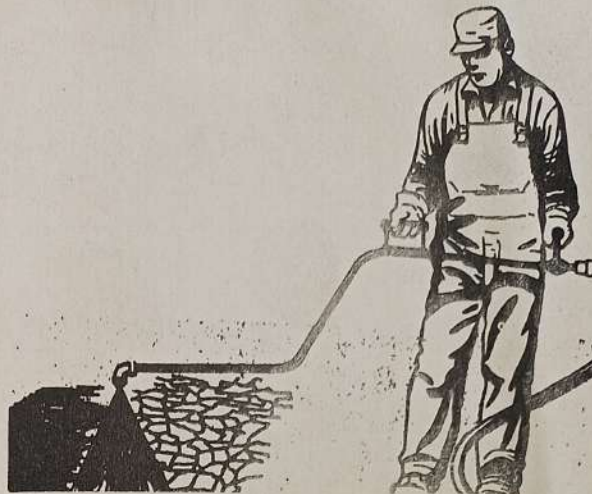
Fig. Núm. 14 - Rociando Asfalto en Grietas de Cocodrilo.
