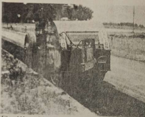
Fig. Núm. 20 - Compactador con Rolo.
