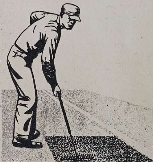
Fig. Núm. 55—Esparciendo Mezcla de la Planta.
