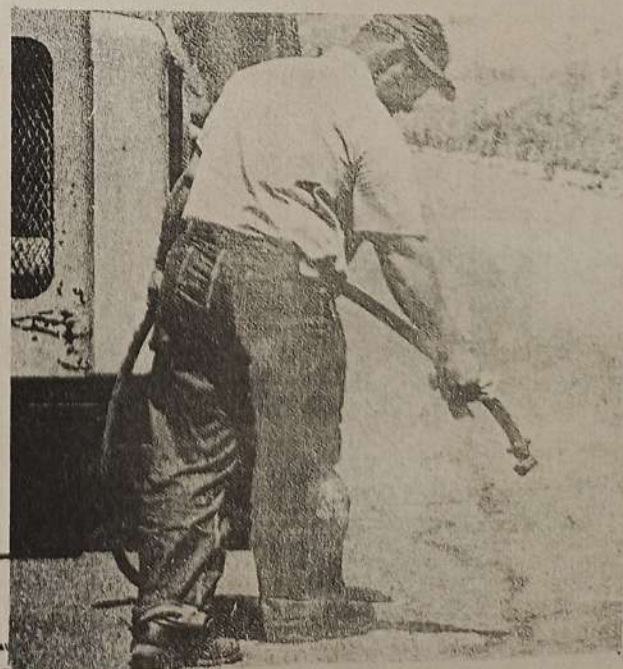
Fig. Núm. 28 - Limpiando Grietas de Contracción con Aire Comprimido.
