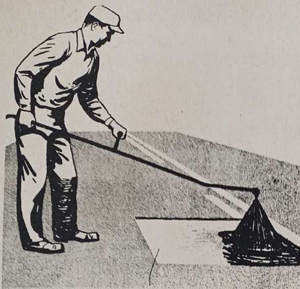
Fig. Núm. 54—Aplicando una Capa Ligante.
