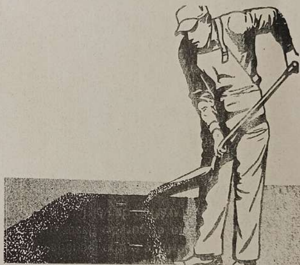
Fig. Núm. 15 - Aplicando Agregado de Cubrición.
