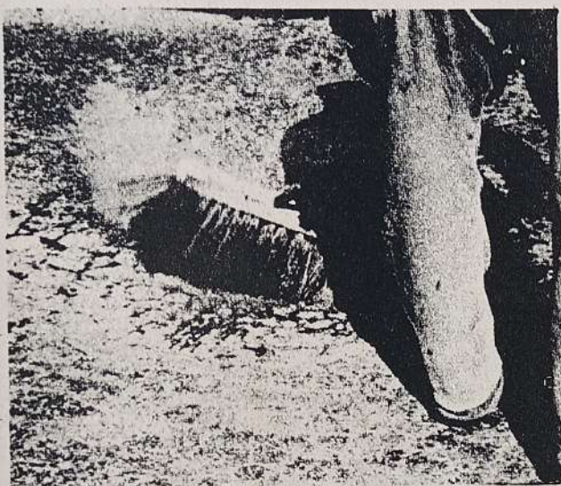
Fig. Núm. 63 - Limpiando el Hoyo de todo Material Suelto.
