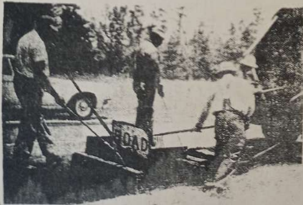
Fig. Núm. 19 - Regando Material Asfáltico Mezclado en Planta en el Borde Asentado.
