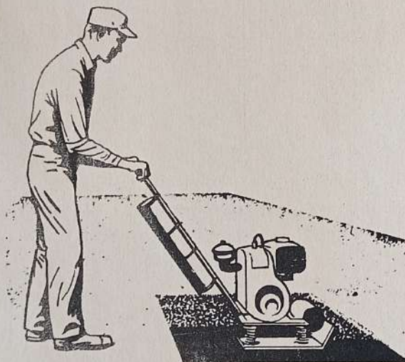
Fig. Núm. 57 - Compactando el Parcho.
