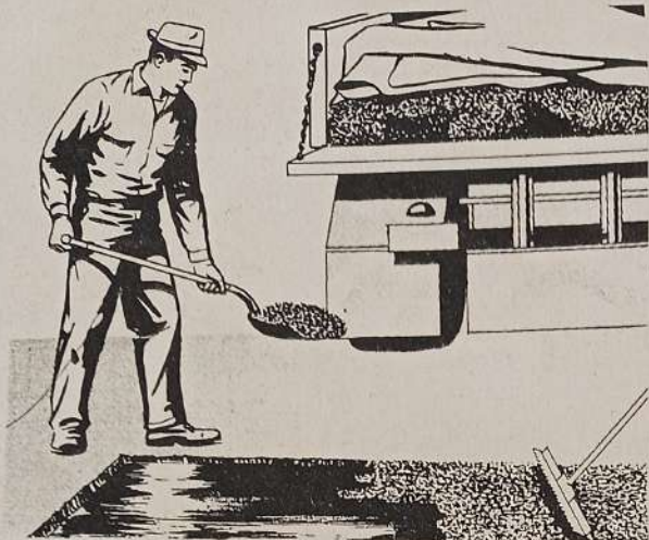
Fig. Num. 12 - Aplicando Parcho Fino de Mezcla Caliente de la Planta.
