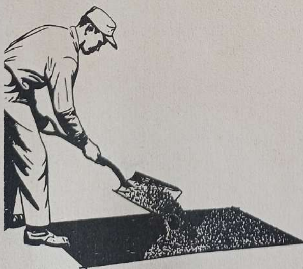
Fig. Núm. 36 - Depositando Mezcla de la Planta en el Espacio Cortado.
