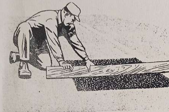
Fig. Núm. 56 - Verificando el Nivel con la Regla.
