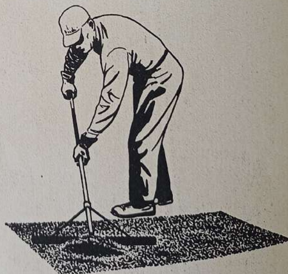
Fig. Núm. 37 - Emparejando la Mezcla del Parcho.
