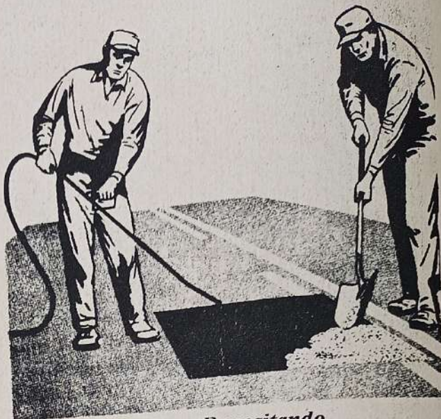
Fig. Núm. 58 - Depositando Sello de Arena.
