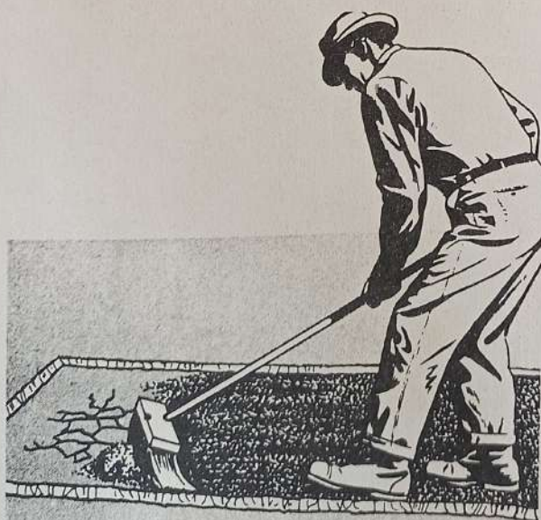
Fig. Núm. 9 - Barriendo Mezcla de la Planta en las Grietas de Cocodrilo.
