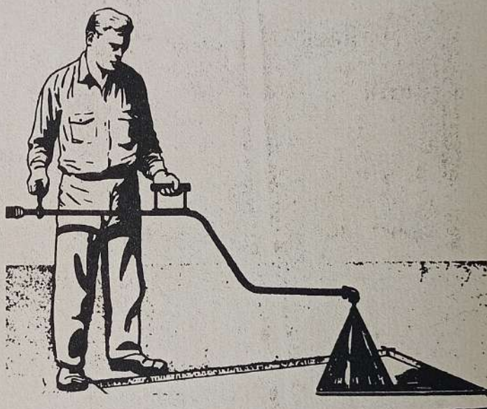
Fig. Núm. 35 - Aplicando Cupa Ligante.
