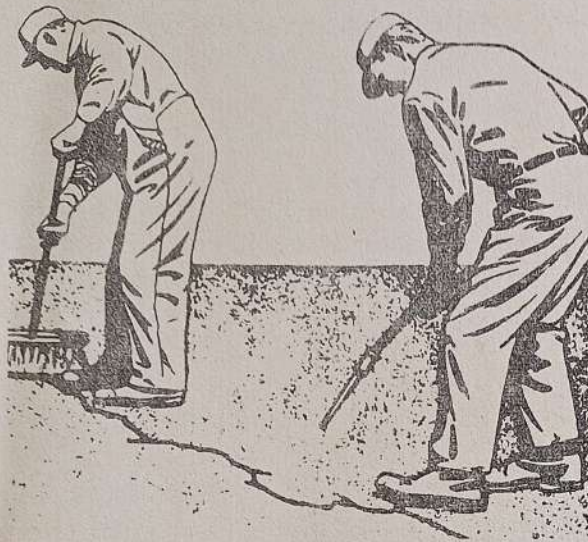
Fig. Núm. 24 - Limpiando la Grieta con Cepillo y Aire Comprimido.
