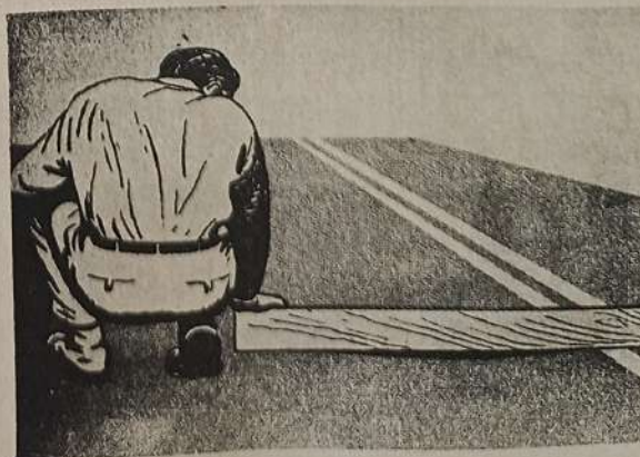
Fig. Núm. 51- Usando Regla para Delinar la Depresión.
