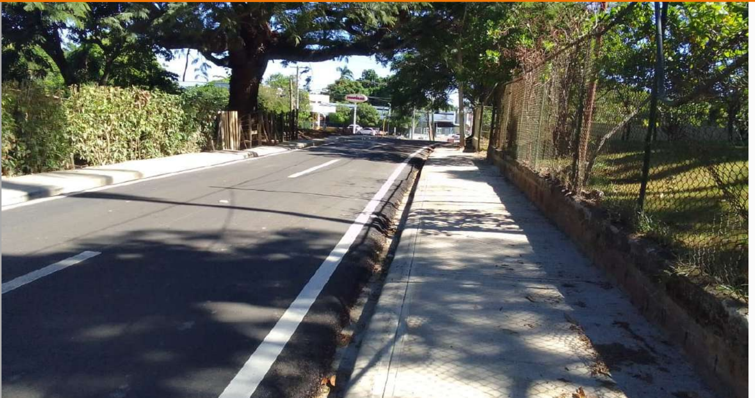
Ampliación y Modernización de la Autopista Duarte
